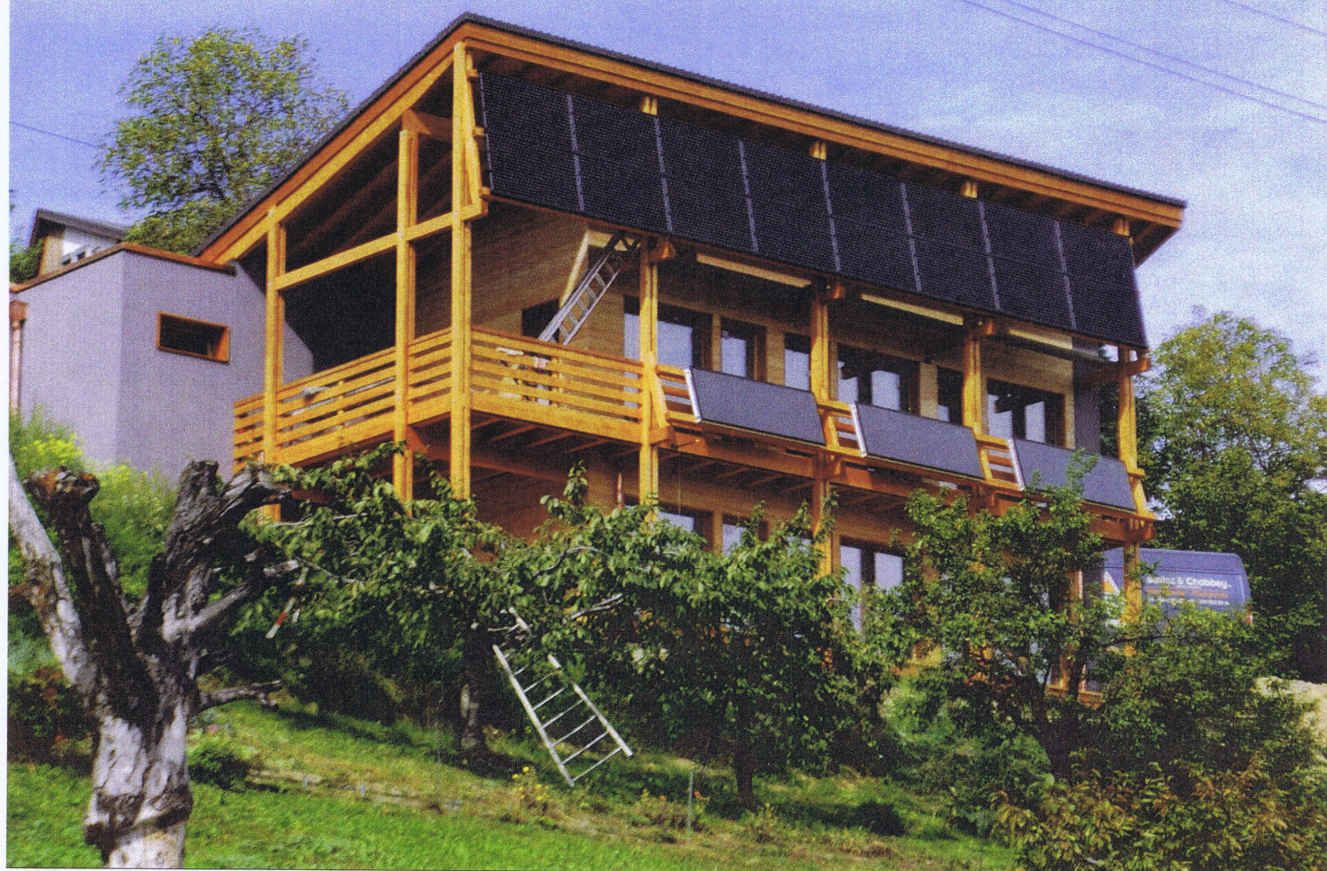
La villa sans chauffage, implantée à 1000 mètres d'altitude, est habitée depuis fin octobre 2014.
